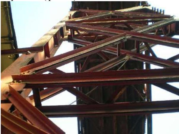
Фото 3. Металлическая маятниковая колонна. Элементы крестовой решетки усилены уголками, распучивание между уголками решетки и полками ветвей колонн (фасонками).
