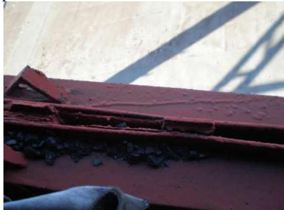
Фото 4. Металлическая ферма верхнего пролета. Разрушение сварных швов между прокладками (сухариками) и парными уголками нижнего пояса.
