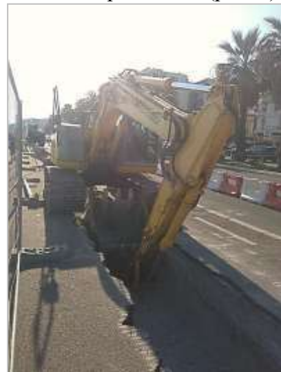
Рис. 3. Устройство стартового и целевого котлованов экскаватором NEW HOLLAND LB 105 (г. Ницца, Франция)
