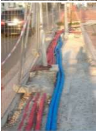
Рис. 2. Строительство и частичная перекладка существующих сетей (питьевого и поливочного водоснабжения, водоотведения, ливневой канализации) открытым способом (г. Ницца, Франция)
