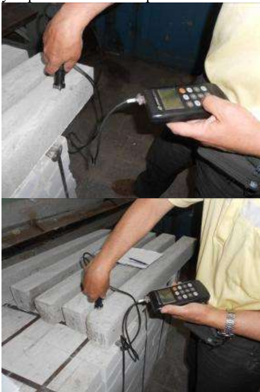
Рис. 10 Определение прочности бетона в опытных образцах балок с помощью склерометра «Оникс»
