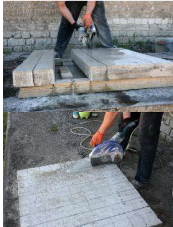
Рис. 4. Разрезка плит на балки
