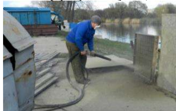
Рис.2. Изготовление опытных образцов плит методом торкретирования
