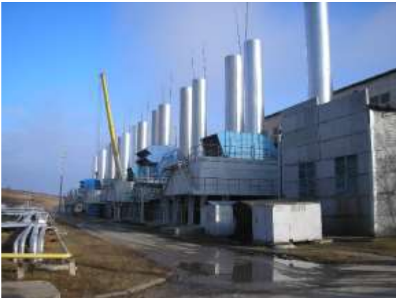
Рис. 1. Металлические дымовые трубы высотой 22.00м компрессорной станции «Заднепровская» магистрального газопровода
