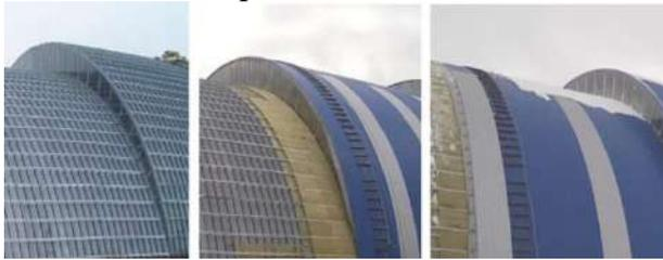
Рис. 3. Бескаркасное сооружение на этапах возведения: а) однослойная система, с установленными Z-прогонами; б), в) процесс утепления и монтажа верхней обшивки
