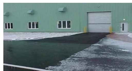
Рис. 4. Состояние дорожных покрытий: а) пандуса; б) площадки въезда в гараж в зимний период при включенных системах греющих электрических матов.
