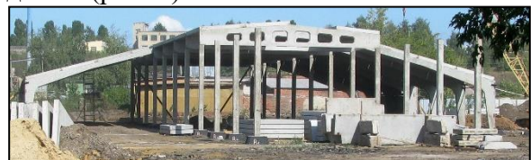
Рис. 1. Загальний вигляд збірного залізобетонного каркаса складської будівлі
