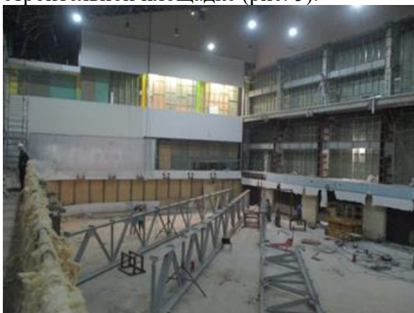
Рис. 5. Укрупненная сборка металлических ферм.
