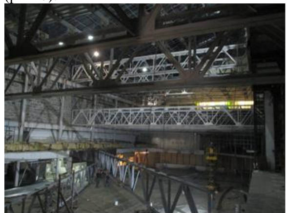
Рис. 7. Монтаж металлических ферм в средней части катка.
