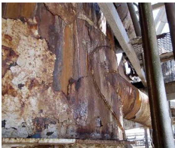
Рис. 2. Корозійний знос стовбура димової труби понад 10%.
