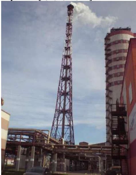
Рис. 1. Металева витяжна труба і несуча вежа цеху «Аміак 4» ВАТ «Акрон» (рік будівництва – 1973 р.).
