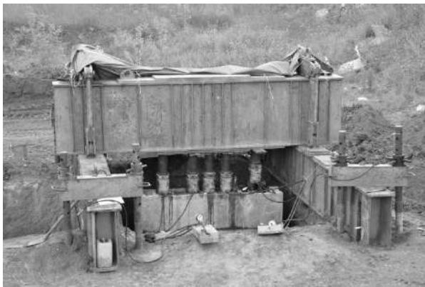
Рис. 3. Общий вид анкерного стенда при испытаниях
