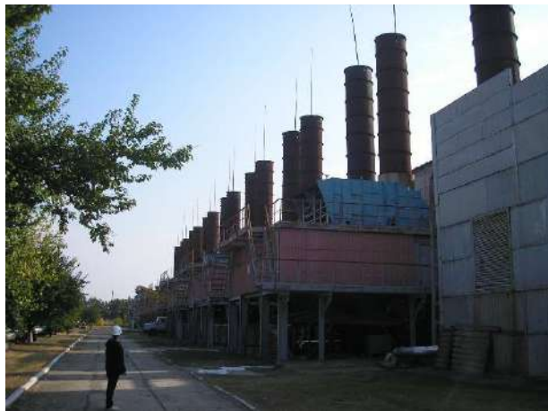
Рис. 1 Металеві димові труби КС «Південнобузька» магістрального газопроводу «Кременчук – Ананьїв – Чернівці – Богородчани».
