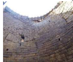
Рис.4 Руйнування кладки футеровки і теплоізоляції труби (а); випинання (утрата стійкості) кладки футеровки димової труби (б).
