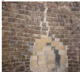
Рис.4 Руйнування кладки футеровки і теплоізоляції труби (а); випинання (утрата стійкості) кладки футеровки димової труби (б).
