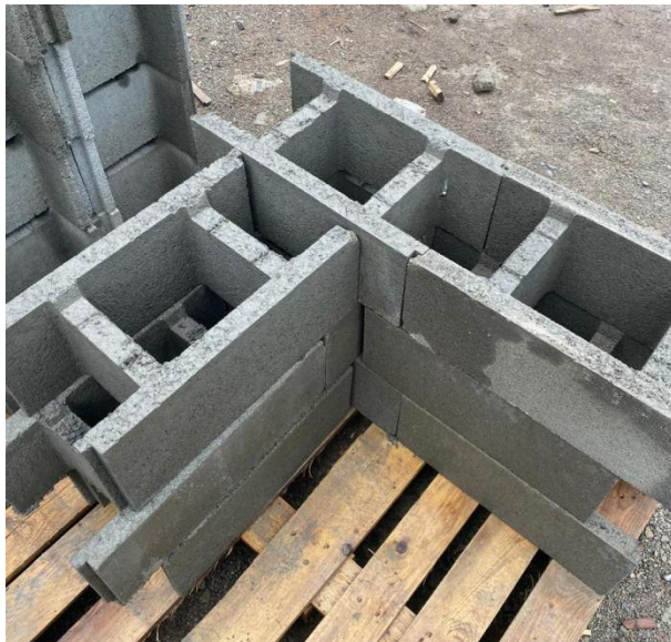
Рис. 1. Блоки незнімної опалубки на будівельному майданчику
