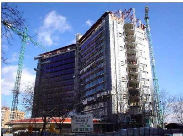
Рис. 1. Фото будівництва готелю, 2003 р. Ресурс: https://www.worldconstructionnetwork.com/projects/hotel-puerta/
