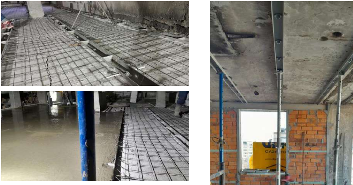
Рис. 3. Процедура відновлення пошкоджених панелей перекриття
