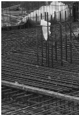
Рис. 1 - Процесс бетонирования плиты перекрытия 23-х этажного каркасно-монолитного ТРЦ «Ковчег».
