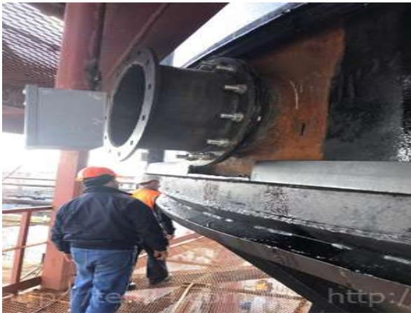
Рис. 1. Размещение наружных частей врезных металлических нагревателей на внешних сторонах резервуаров
