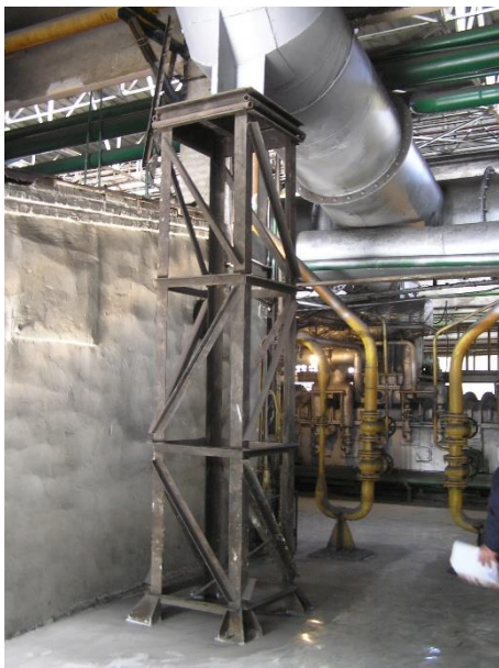
Рис. 3. Металлическая дымовая труба №1 секционной печи №5. Труба опирается на пространственную металлическую опору.
