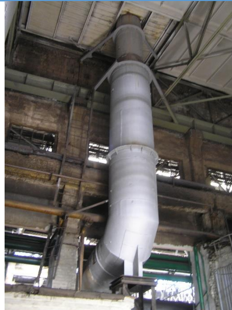
Рис. 2. Металлическая дымовая труба внутри цеха. Труба раскреплена к подкрановой балке и стене и опирается на металлическую сквозную колонну.
