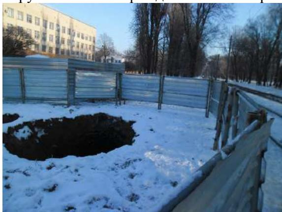
Рис. 6. Обрушение в зоне повреждения коллектора после засыпки грунтом первичного проседания грунта
