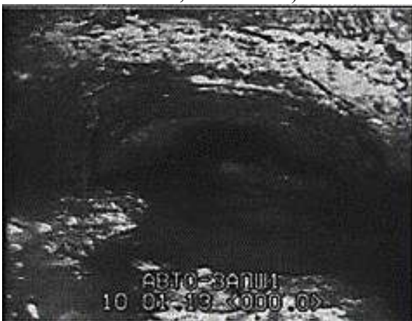
Рис. 5. Канализационный тоннель завода «Автозапчасть», шахта № 1.
