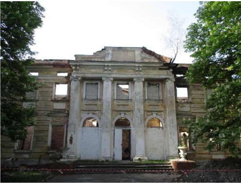
Рис. 2. Загальний вигляд будівлі «Палацу» з північної сторони після пожежі (травень 2018 р.).
