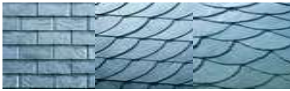
Рис.3. Варіанти укладання сланцевої покрівлі: а) – англійський; б) – французький; в) – німецький.
